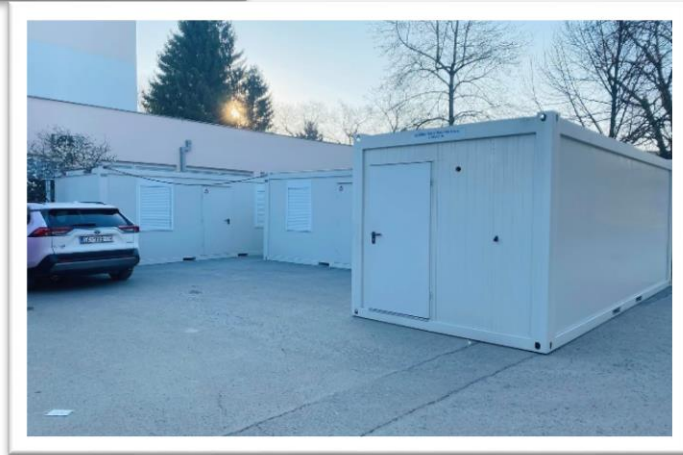
Slika 96: Kontejneri za rad službi Fakulteta ispred oštećene zgrade Fakulteta
